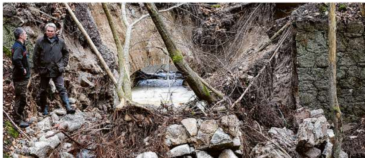
Heftiger Biberschaden: Revierförster Dietmar Discher und der Forstbeamte Jan Engel an der zerstörten Eckernbrücke im Revier Chorin im Jahr 2014.
